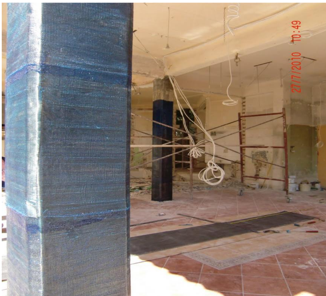
Εικόνα 8 - Αντισεισμική ενίσχυση παλαιότερων κατασκευών με ινοπλισμένα πολυμερή (Πηγή: Προσωπικό αρχείο)
