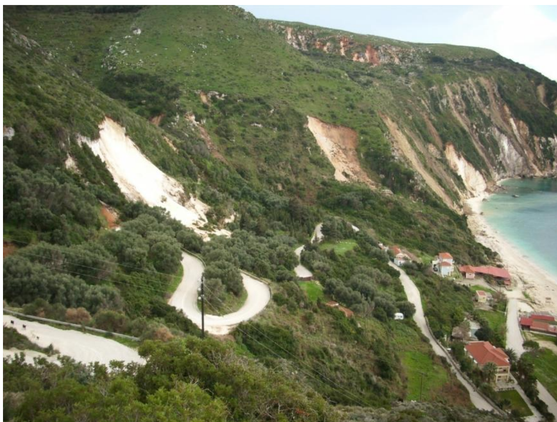
Εικόνα 14 - Κατολισθήσεις ασταθών πρανών κοντά σε μικρό οικισμό που οδήγησαν στην εκκένωσή του (Πηγή: Δήμος Κεφαλονιάς – Δ/νση Πολιτικής Προστασίας).
